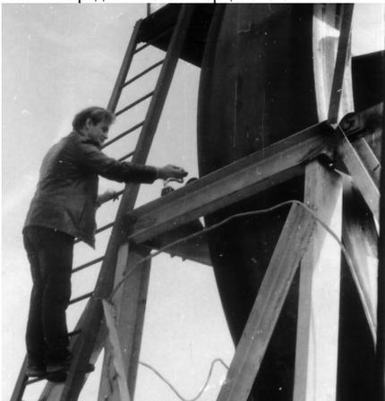
Рис. 1. Измерение биения поверхности качения бандажа (операция 005)
