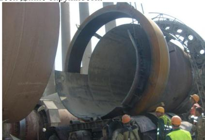
Рис. 3. Демонтаж бандажа с ТБ (операция 015)
