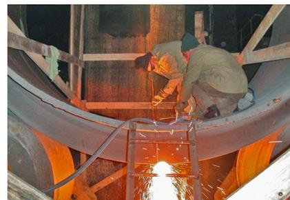
Рис. 7. Сборка реконструированного бандажа с кольцевыми обечайками, с использованием электрошлаковой сварки (операция 025)
